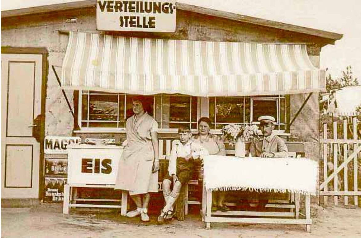
Das Foto aus der Chronik des Vereins „Feldtmannsburg“ zeigt eine Waren-Verteilungsstelle in den 1920er Jahren. Vor allem Petroleum, Karbid und anderes Material für den Garten wurden dort ausgegeben, später auch Süßigkeiten für die Kinder. Quelle: Verein Feldtmannsburg e.V.
