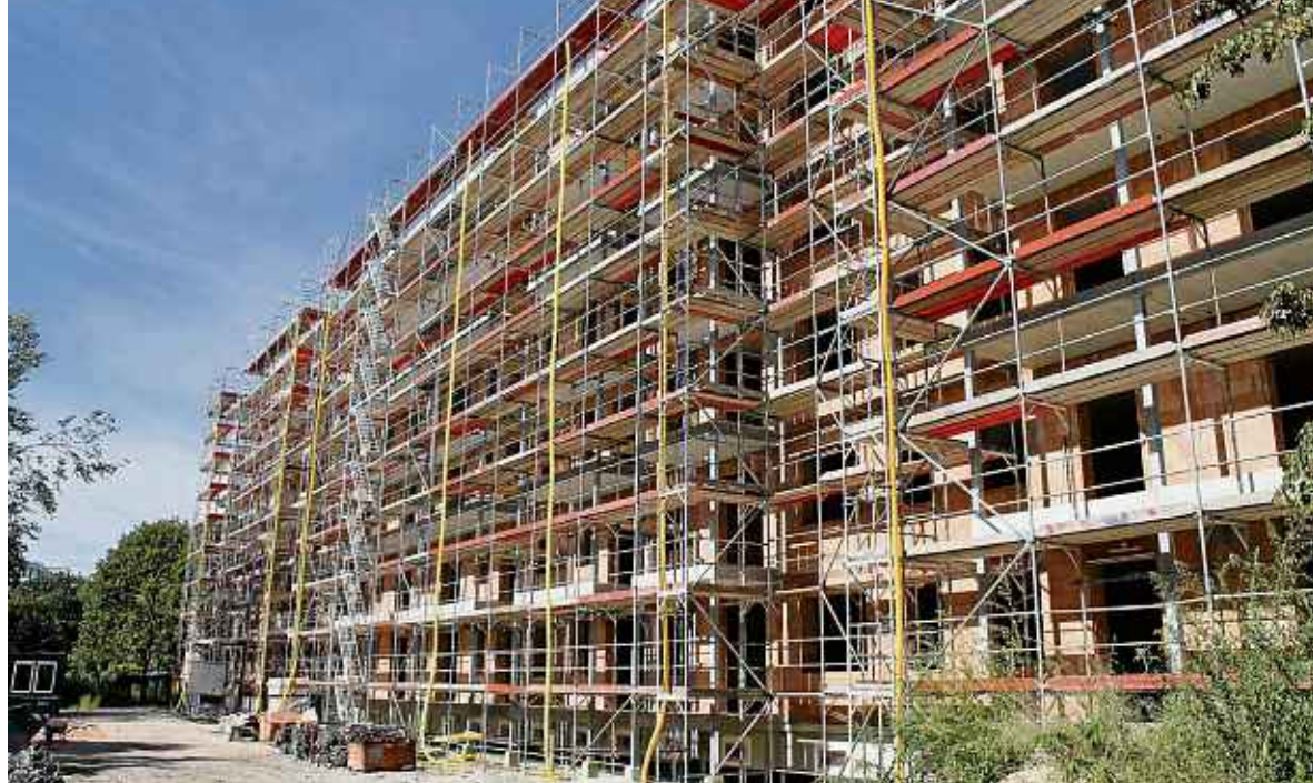
Der Bau wird aus roten Poroton-Ziegeln errichtet. Dadurch kann auf eine teure Fassadendämmung verzichtet werden. Foto: BA
