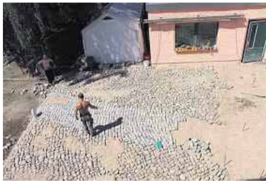
Pflasterarbeiten vor dem Storchencafé
