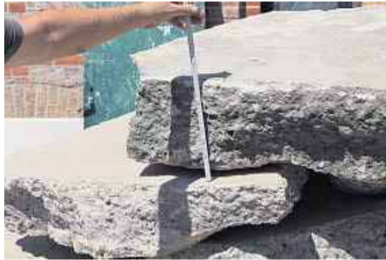
Die Betonversiegelung wurde entfernt
