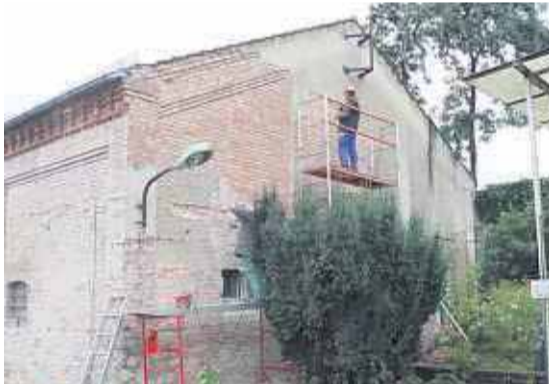
Die ursprüngliche Klinkerfassade wurde vom Putz befreit
