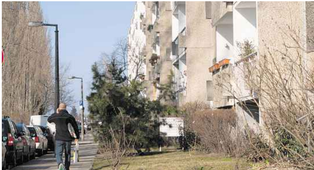
Die Wohnhäuser an der Anna-Ebermann-Straße sollen saniert werden.
