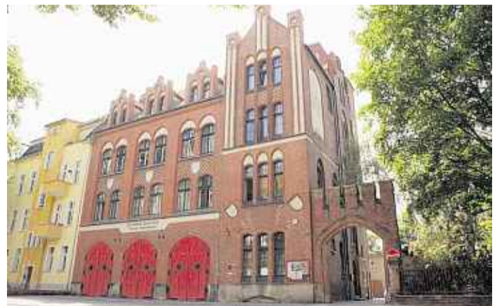
Die von Gregorovius erbaute Feuerwache in der Dönhoffstraße 31
