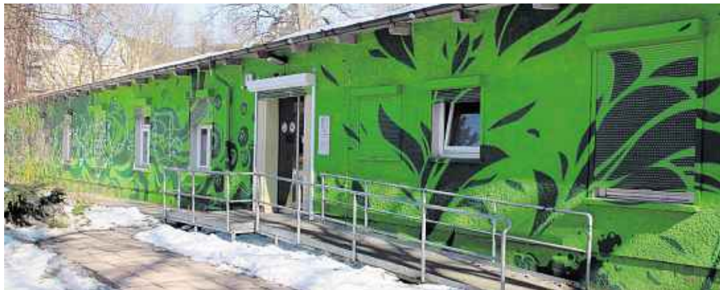
Wird bald dem Erdboden gleich gemacht: Die Baracke neben dem Rathaus, in der das Bürgeramt 2 zu finden ist. Das Amt zieht ein paar hundert Meter weiter in die Normannenstraße.
