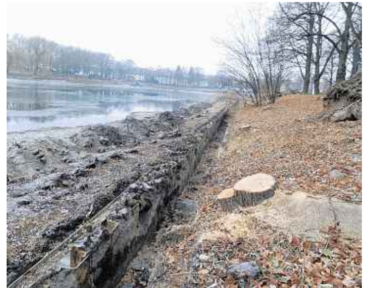
Derzeit finden am Orankesee Sanierungsarbeiten statt, um den Naturschutz langfristig zu erhalten und die Wassergüte zu verbessern. Fotos: BA
