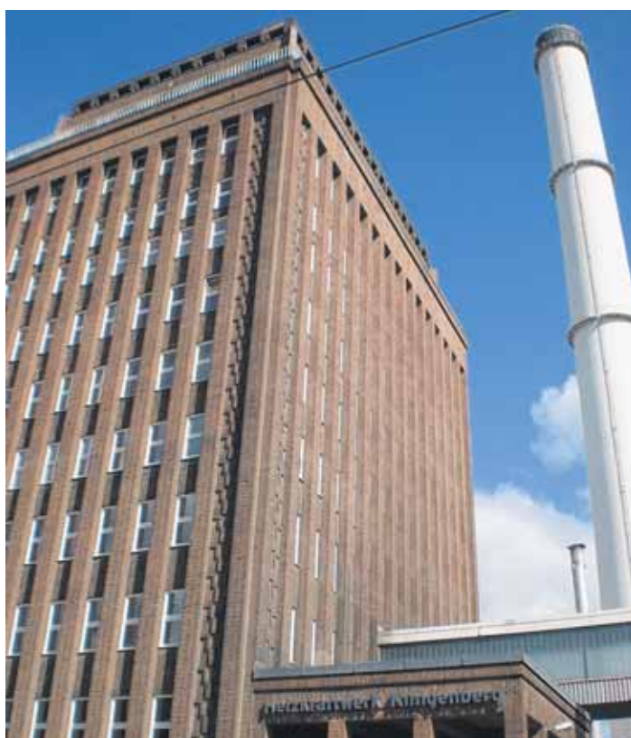
Den architektonischen Hauptakzent des Denkmals Kraftwerk Klingenberg setzt ein streng vertikal gegliedertes elfgeschossiges Verwaltungshochhaus mit ornamentaler Klinkerverblendung und zurückgesetztem Dachaufbau.
