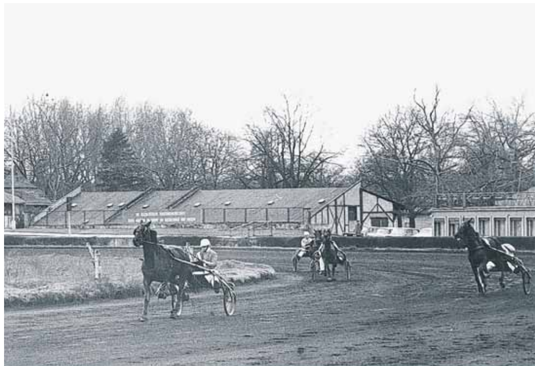
Historische Aufnahmen von der Trabrennbahn Karlshorst.
