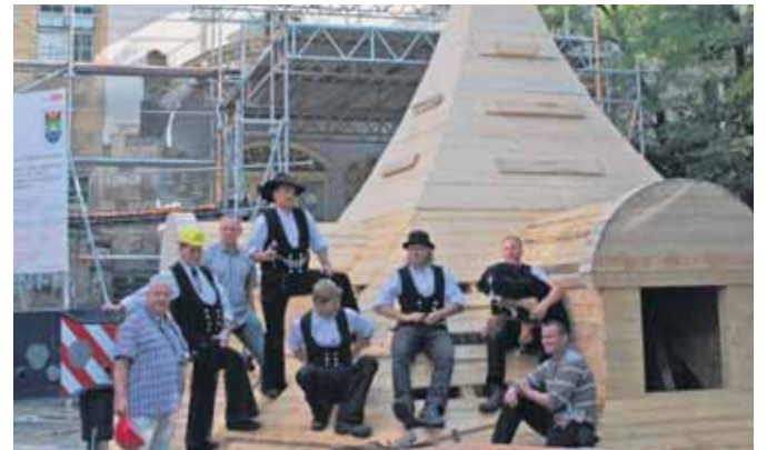
10. August, 9 Uhr: Zimmerleute der Firma Regen&Barth aus Leipzig vor Beginn des Aufzugs der Konstruktion.
