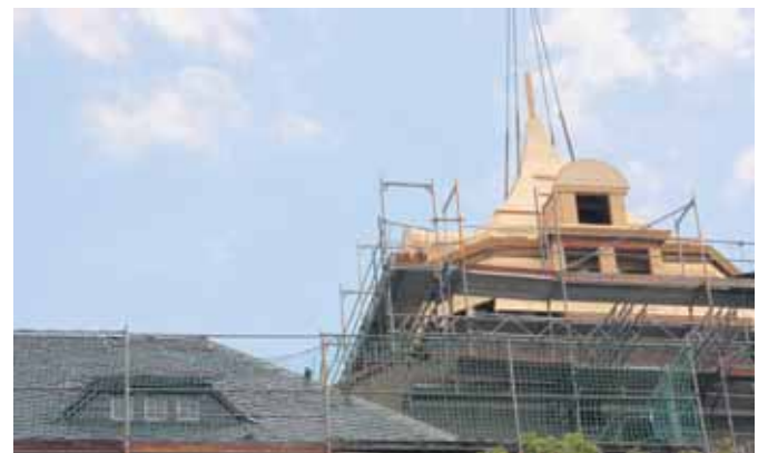
Der Kran hebt die Holzkonstruktion aufs Turmfundament.
