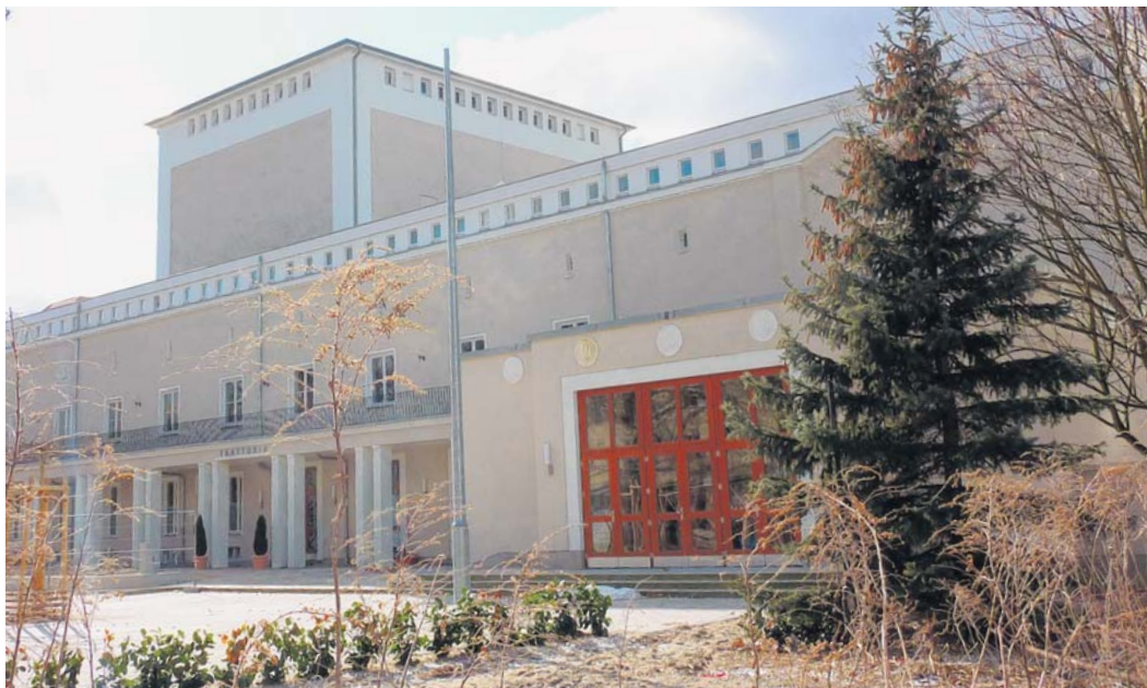
Das Theater wurde von der Eigentümerin in den vergangenen Jahren umfassend saniert.
