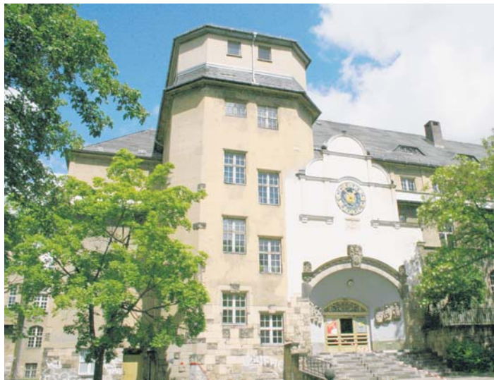
Portal der Rathausschule im Vorjahr. Der Turm wird derzeit wieder aufgebaut. Foto: GWA-Umweltconcept
