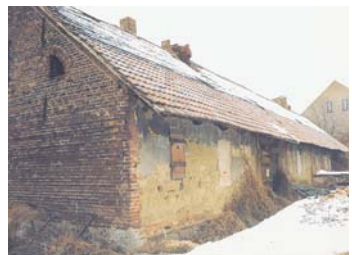
So sah das ehemalige Gutsarbeiterhaus in der Falkenberger Dorfstraße 4 zehn Jahre zuvor aus.
