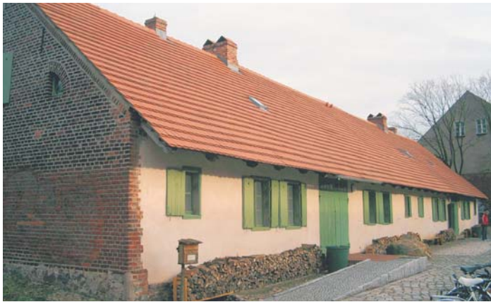
Blick vom Hof auf das Haus im Jahr 2007 nach der Sanierung.
